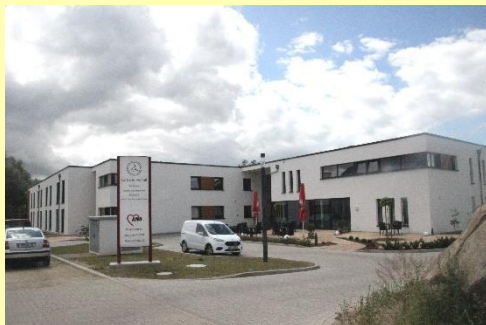
AWO-Heim „Haus der Vielfalt“ (Goethestraße)
