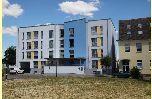
Sozialstation Peene gGmbH. (Baustraße)
